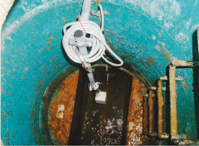
Figura 2 - Sensore di livello e sonda piezoresistiva
