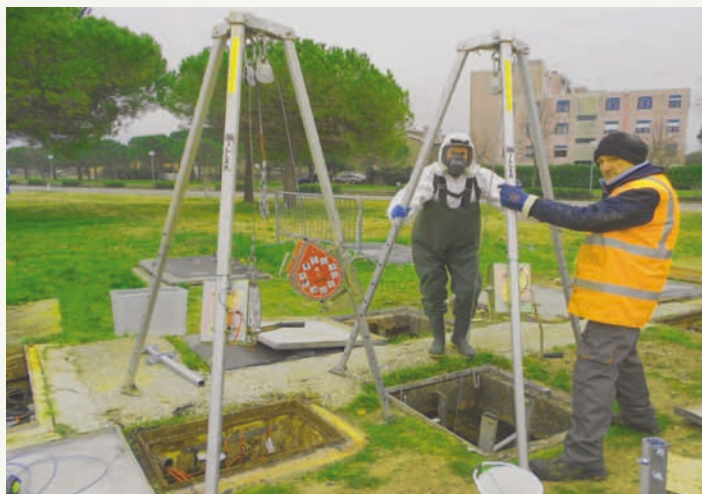
Figura 4 - Installazione strumentazione mediante dispositivi anticaduta
